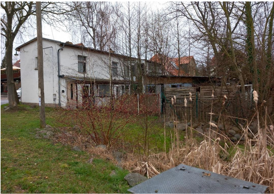
Ansicht angrenzende unbewohnte Bebauung im Norden des Löschteichs
