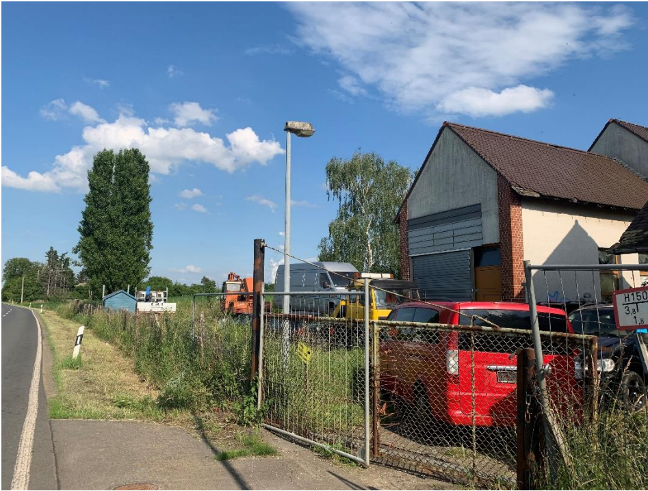
Ansicht östliche Hofeinfahrt
