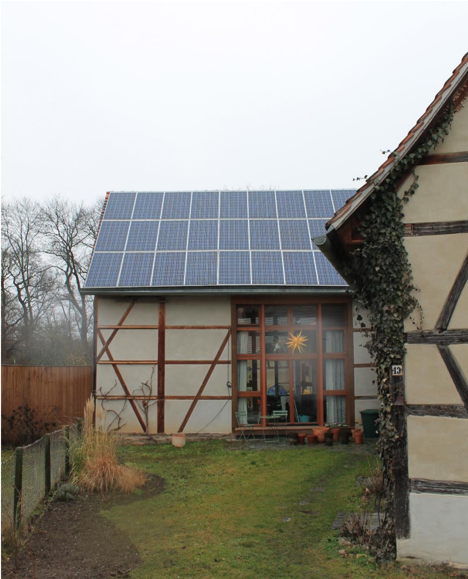
Ansicht Süd-West auf zu Wohnraum umgebautes Seitengebäude und Scheune mit PV-Anlage
