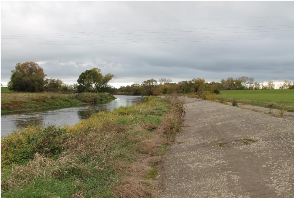
Künstlicher Flußlauf der „Beton“-Elster
