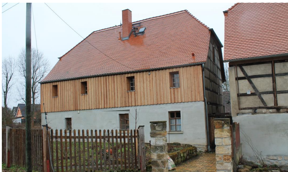
Ansicht Süd-Ost auf Wohngebäude und Seitengebäude
