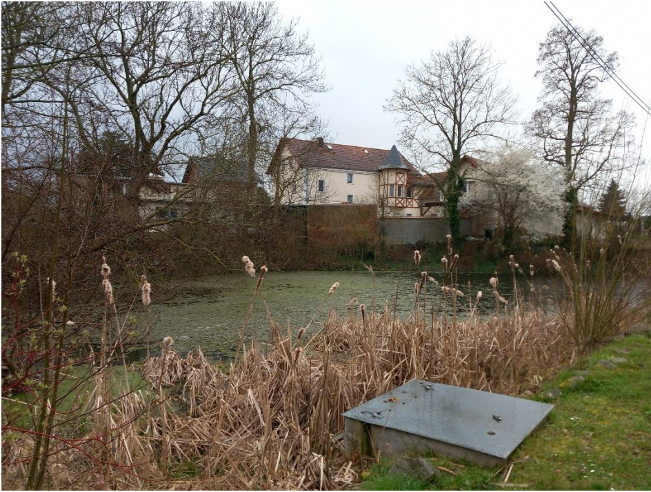
Ansicht Löschteich von Norden
