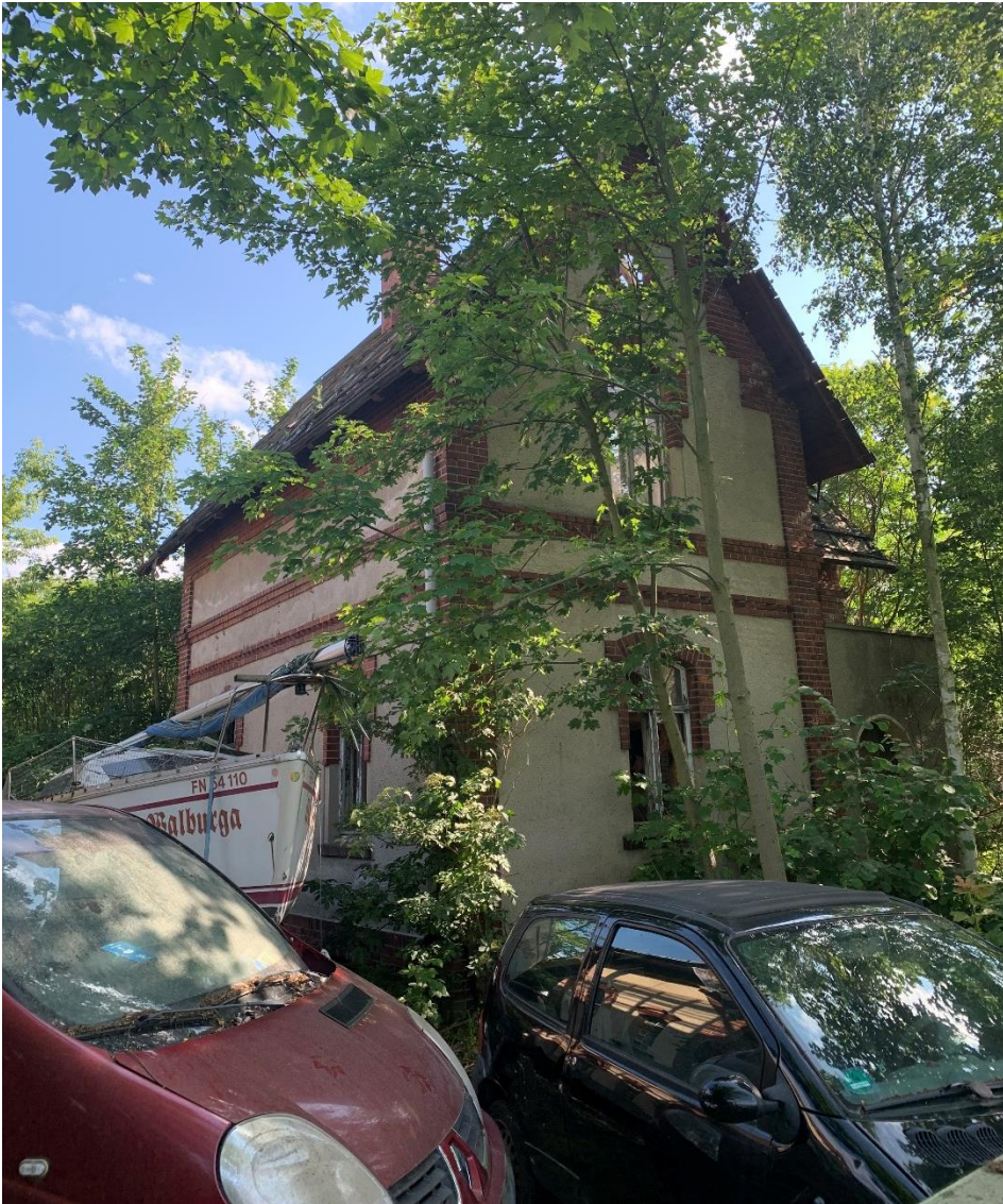
Ansicht westliches Nebengebäude
