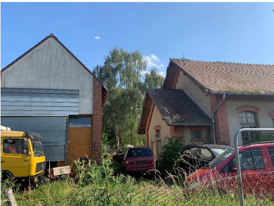
Ansicht östliches Nebengebäude und Hauptgebäude
