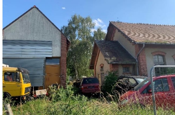
Abb. 7: Ehemaliges Wasserwerk in Rüssen-Kleinstorkwitz
