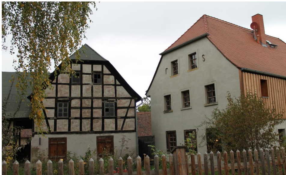
Ansicht Süd auf leerstehendes Nebengebäude und Wohngebäude
