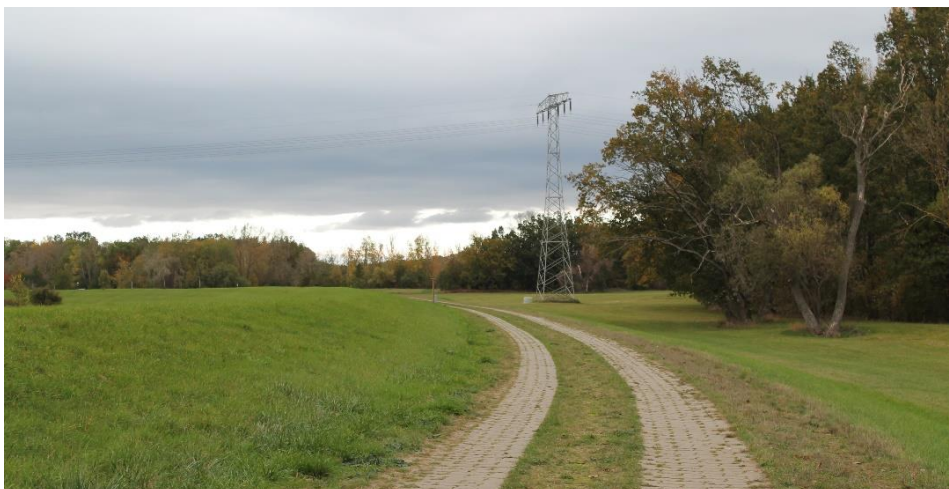
Deichverteidigungsweg auf dem Damm entlang der Weißen Elster
