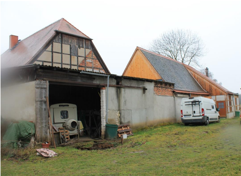
Ansicht Nord-Ost auf Seitengebäude und Werkstattgebäude
